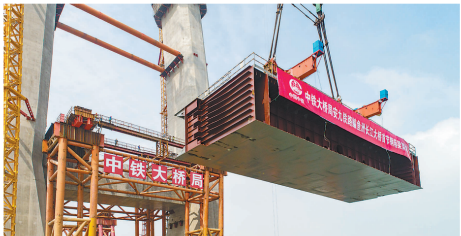
5月26日拍摄的鳊鱼洲长江大桥钢箱梁架梁现场。
