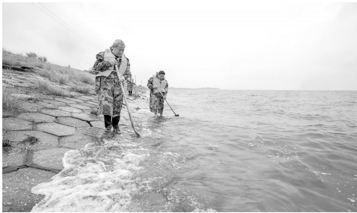
7月5日,在鄱阳湖都昌矾山下坝,北山乡干部群众在坝外巡查险情。近期,受强降雨及长江洪水共同影响,鄱阳湖发生超警戒洪水并持续上涨。 特约通讯员 傅建斌摄
