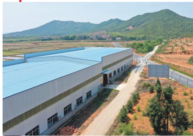
正在建设中的扶贫车间。
