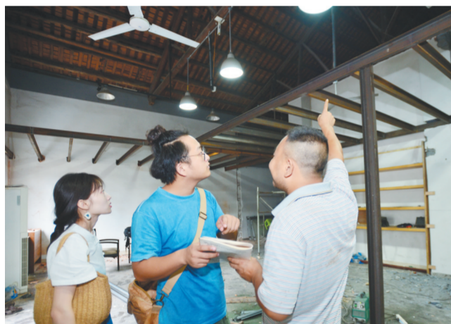
王云伯(中)和吴露正与装修工人商量新工作室的装修风格。
