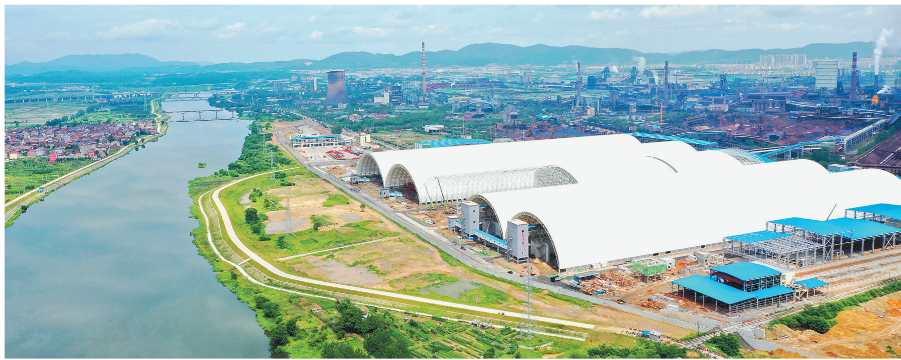
新钢公司综合料场智能环保易地改造项目已竣工,白色的巨型钢棚格外醒目。 通讯员 张海海摄
