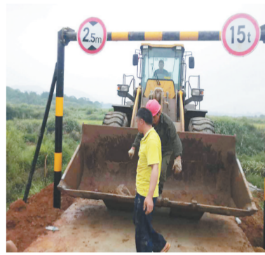
工人正在机耕桥头设立限高架。
