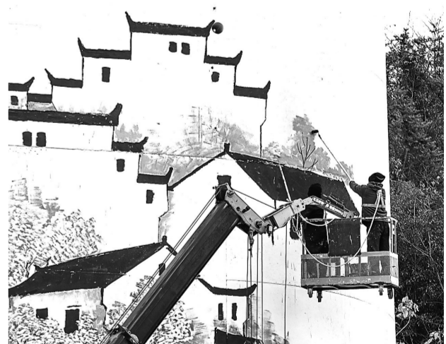
近日,婺源县对全县公路、铁路桥墩及高速隧道口进行彩绘,画上该县“春赏五色芳菲,夏踏清幽山水,秋观红枫晒秋,冬享古韵民俗”的四季风景。
