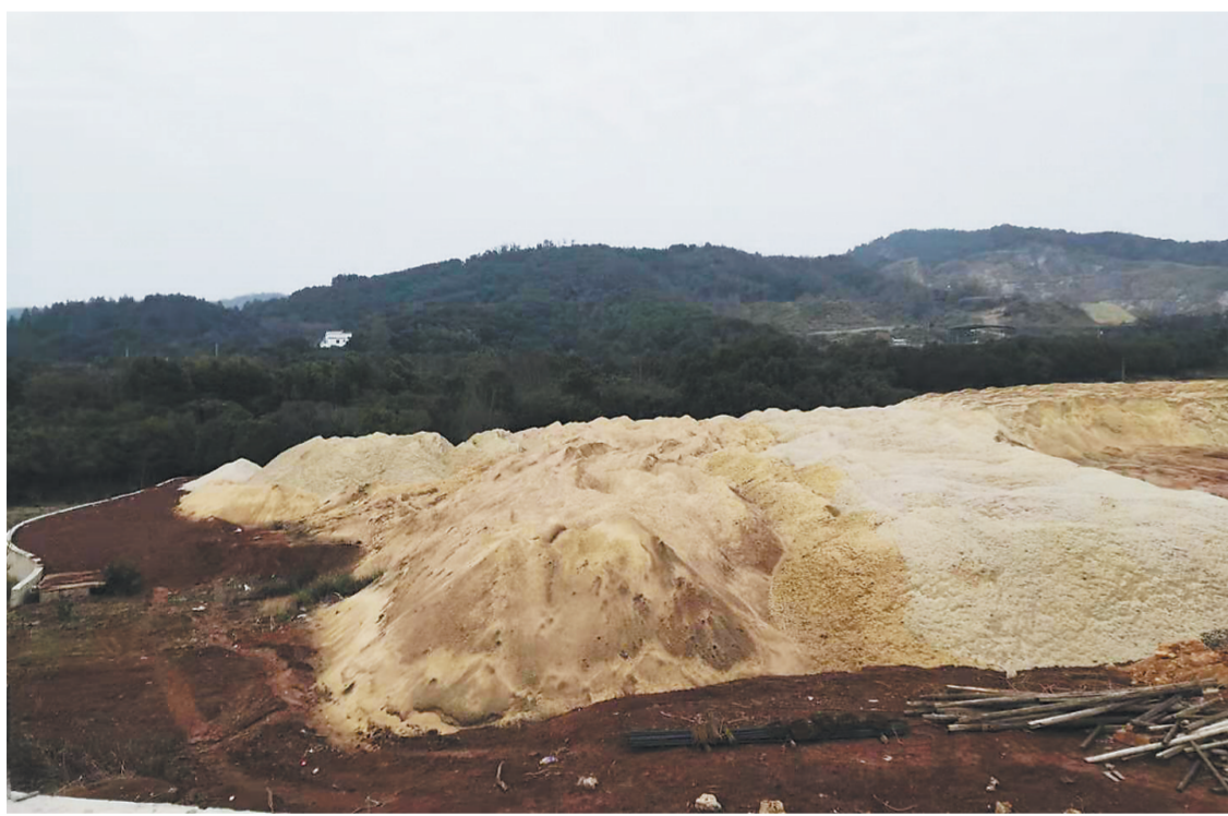
赣昌砂石新建区配送站占用农田堆放砂石。
