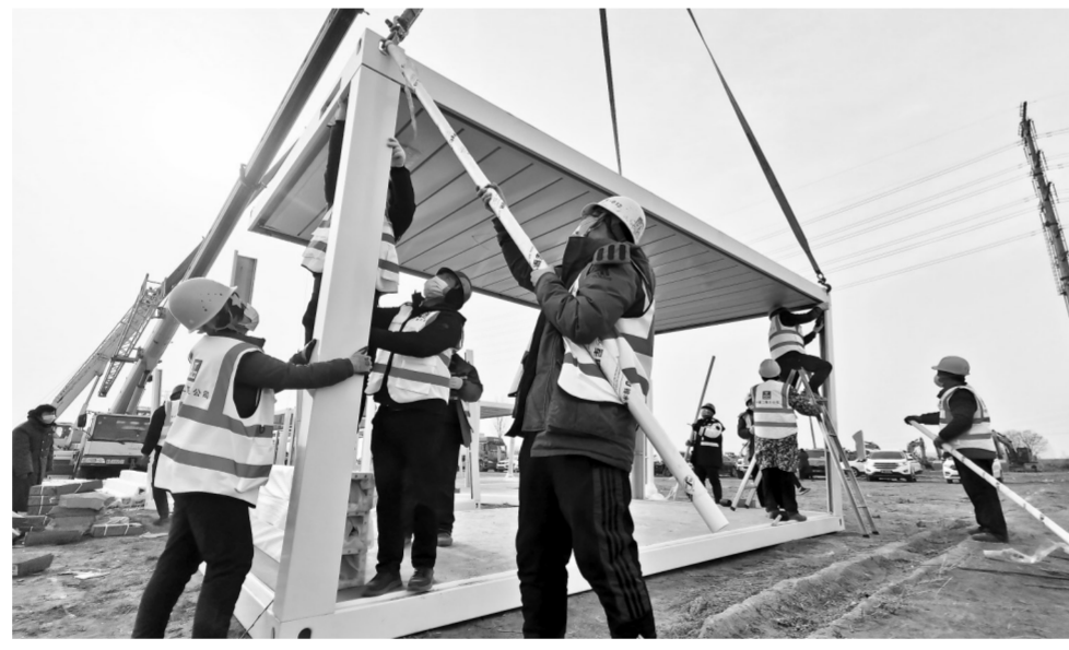
▲1月14日，工人在石家庄市集中隔离点建设工地施工。 新华社记者 杨世尧摄
