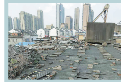
经通过验收,总共花了80多万元。”龚雪说,顶楼的居民再也不担心房屋漏水,安全隐患也消除了。看到改造好的屋顶,以及更换到位
