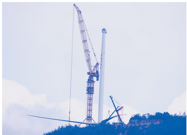
4月24日,国家电力投资集团投资建设的泰和县浪川风电项目正在进行风机吊装施工作业。近年来,泰和县推进清洁能源建设,助力高质量发展。 特约通讯员 邓和平摄
