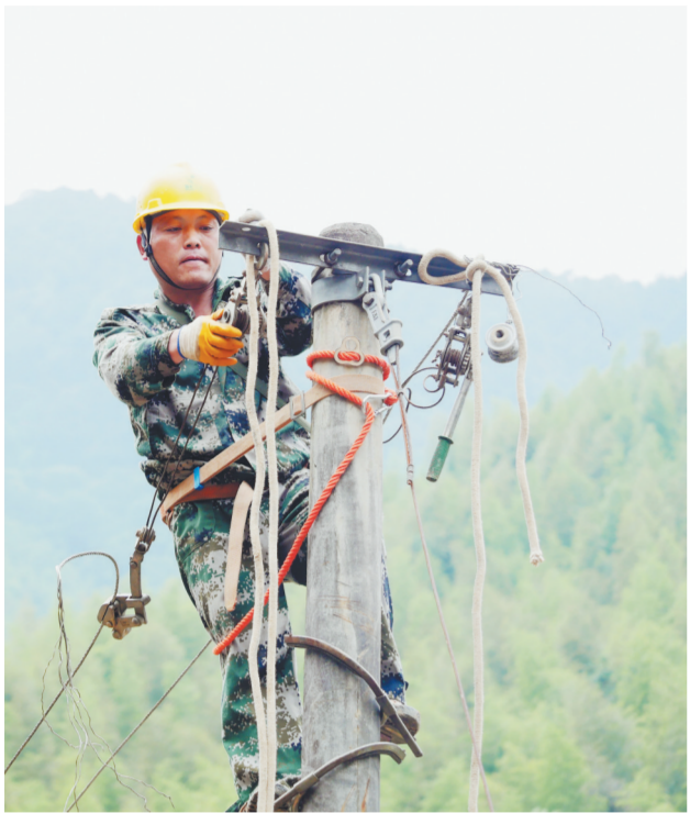
5月25日,国网奉新供电公司工作人员在黄石村进行变压器增容改造。今年黄石村光伏发电项目装机容量增加到150千瓦,现有变压器无法满足并网需求。该公司决定把现有的100千伏安变压器增容到200千伏安,并以最快速度安排施工。
