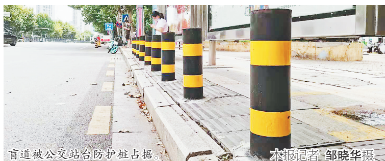
盲道被公交站台防护桩占据。 本报记者 邹晓华摄
