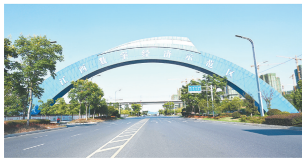
江西数字经济示范区
