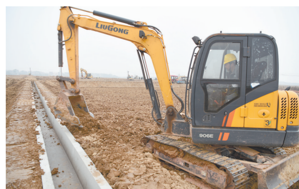
12月13日,在南昌市新建区松湖镇竹洲高标准农田建设现场,挖掘机在田埂里来回作业,平整出连片土地。入冬以来,新建区利用天气晴好的有利时间,抓紧开展高标准农田建设,对全区5万多亩农田集中改造。 本报记者 宗欢摄
