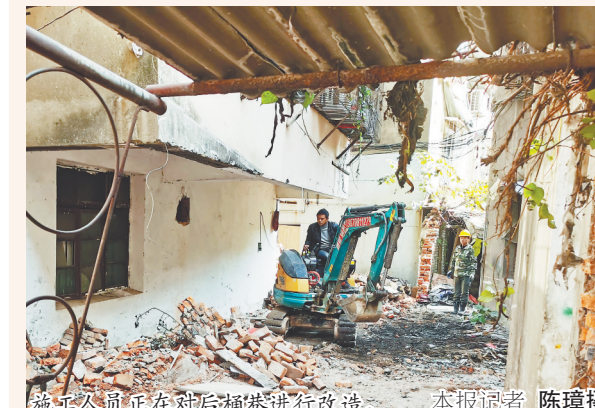
施工工人正在对后桶巷进行改造。 本报记者 陈璋摄
