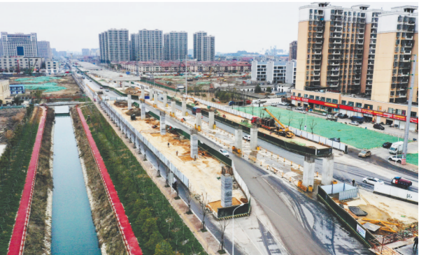
南昌市九洲高架东延工程洪都大道至天祥大道路的核心工程——天祥立交南北主线桥已成功完成墩身、盖梁等下部结构施工，正在进行上部结构架梁及桥面附属结构施工。该工程总长11.93公里，建成后，将进一步完善南昌快速路网，缓解城东片区交通压力。通讯员 帅婷摄
