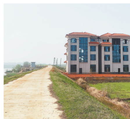
紧挨防洪河堤的两栋楼房。本报记者 陈璋摄
