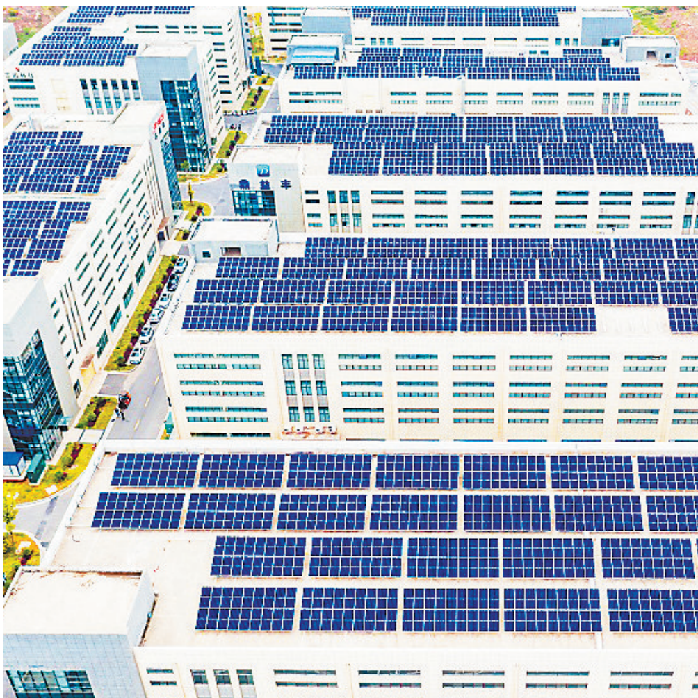
3月31日,航拍下的赣州经开区华昌科技园屋顶的光伏发电板整齐排列,璀璨耀眼。近年来,该区充分利用园区厂房屋顶闲散资源建设光伏发电项目,创造经济效益,助力实现碳达峰碳中和战略目标。
