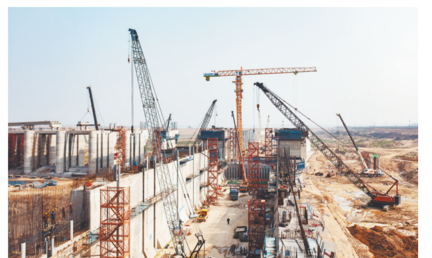
正在建设中的船闸闸室。
