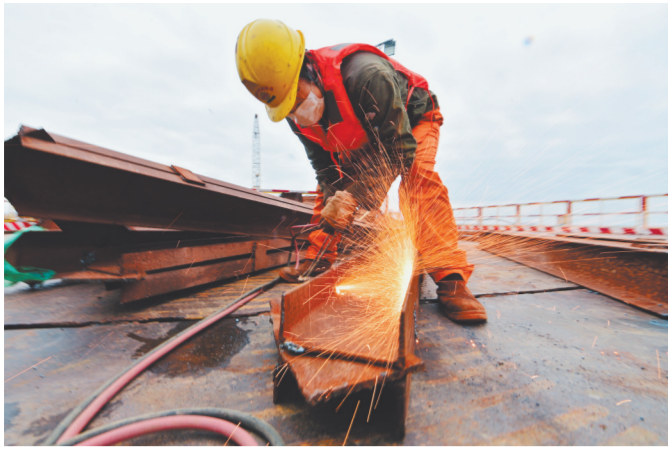
工人在切割钢梁。
