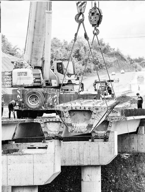
►4月29日,在G323国道改建工程赣州市章贡区沙河镇段,施工人员正在进行施工作业,铺设预制桥梁。该工程是省重点公路项目,建设者们在确保安全和质量的同时,抢抓工程进度,确保工程建设如期推进。本报记者 唐燕摄
