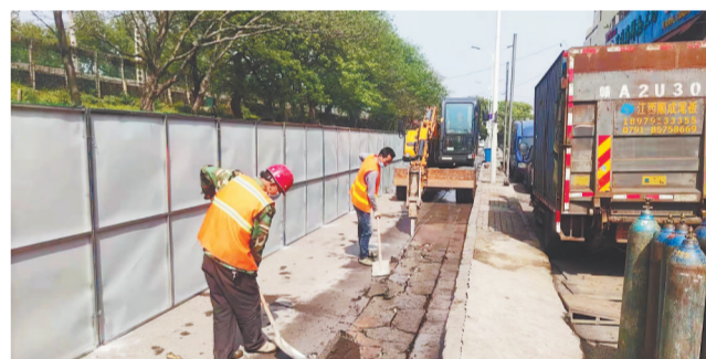
施工人员在摊铺路面。 本报记者 蔡颖辉摄
