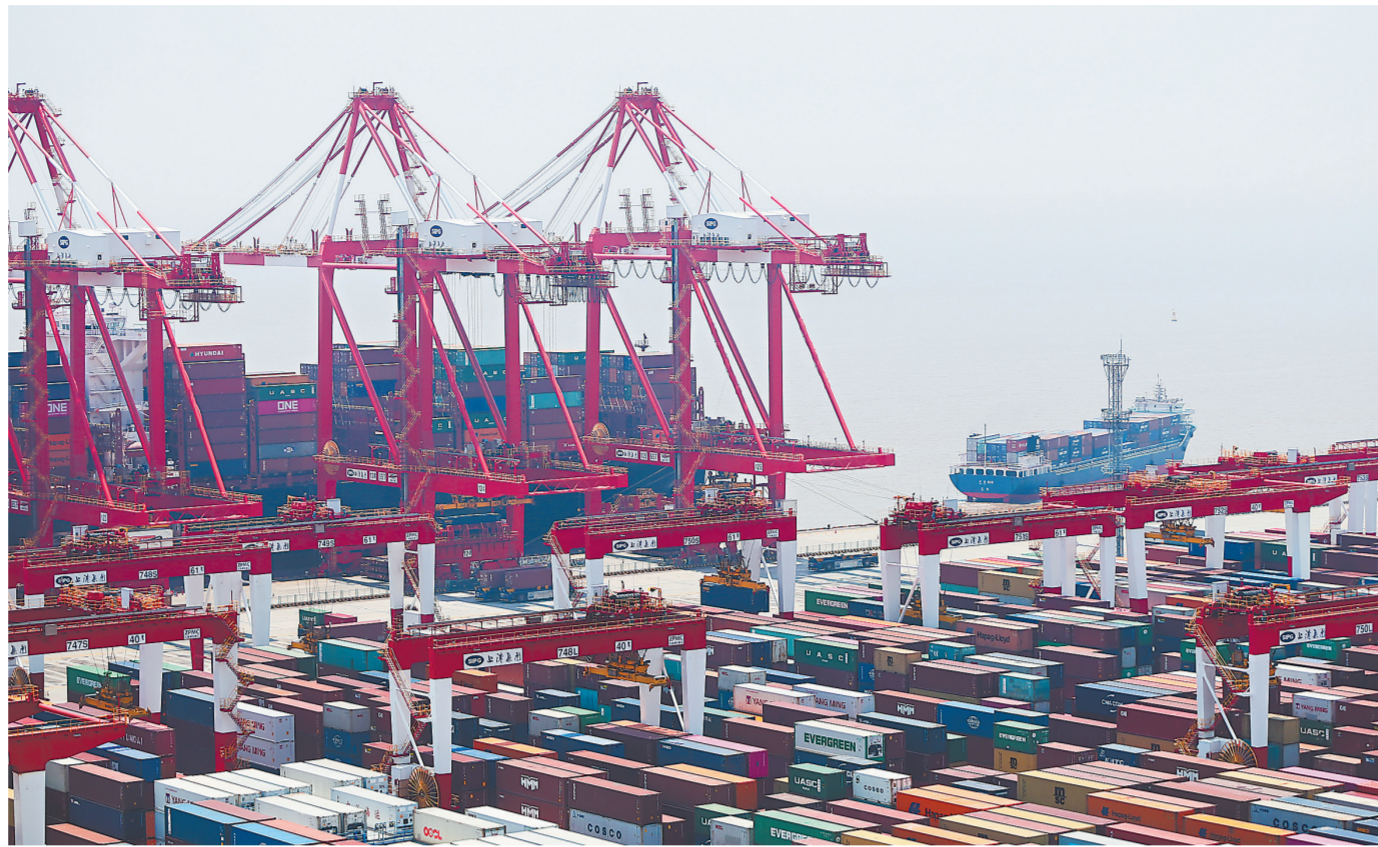
5月17日拍摄的上海洋山深水港四期自动化码头。
