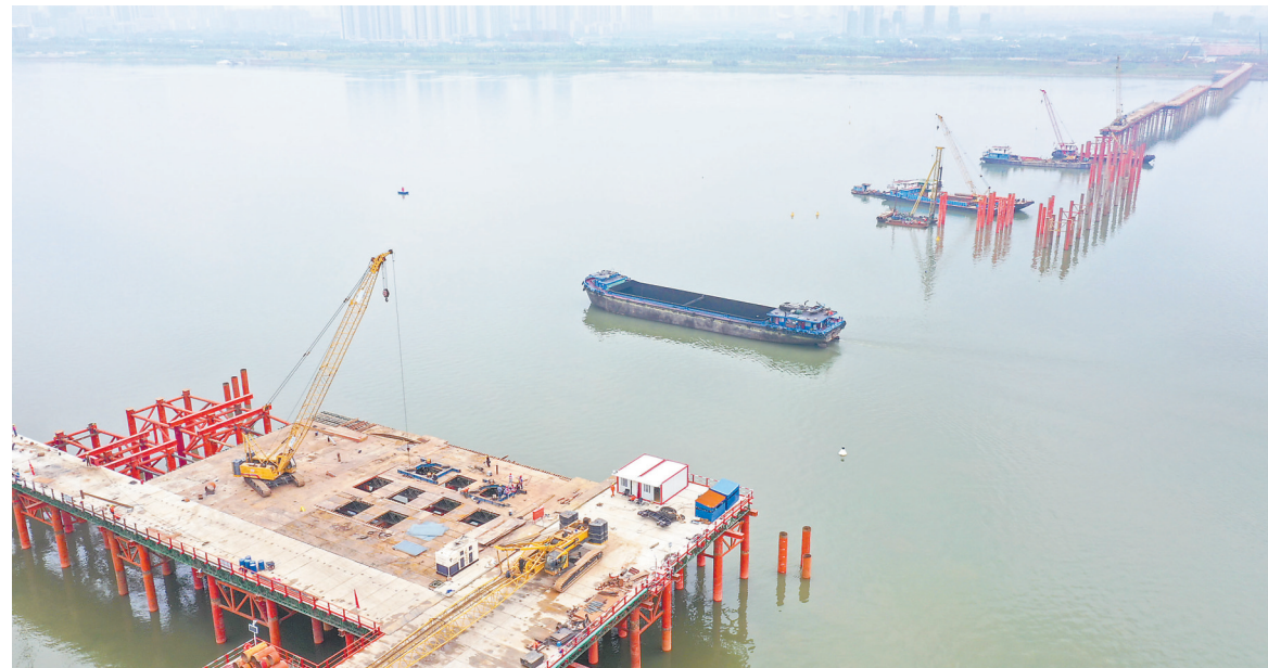
施工忙 5月24日,在南昌市洪州大桥项目建设现场,工人正在加紧施工作业。据了解,洪州大桥项目主线全长约3.94公里,总投资约20.81亿元,预计2024年竣工通车。 史浩泽摄
