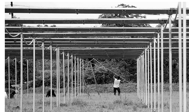
6月9日,乐安县公溪镇荷波村村民正在搭建蔬菜钢架棚。近年来,荷波村采取“公司+基地+示范户”等模式,壮大村集体经济,带动百姓增收致富。特约通讯员 林志超摄
