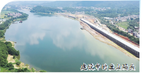
建设中的鱼山码头
