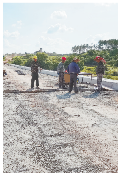
工人正在进行郑屋大桥的扫尾施工。
