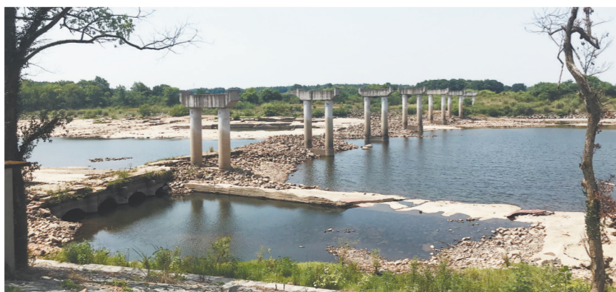
停工的耙石大桥。
