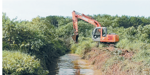
村里请来挖机拓宽沟渠。
