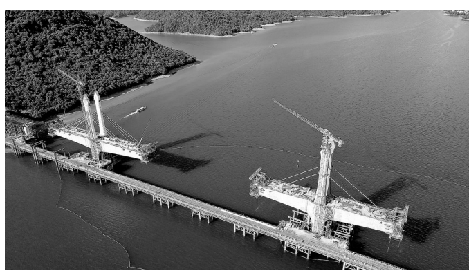
▲这是正在建设中的中国铁建大桥局池黄铁路太平湖特大桥(8月12日摄,无人机照片)。新华社记者 刘军喜摄
