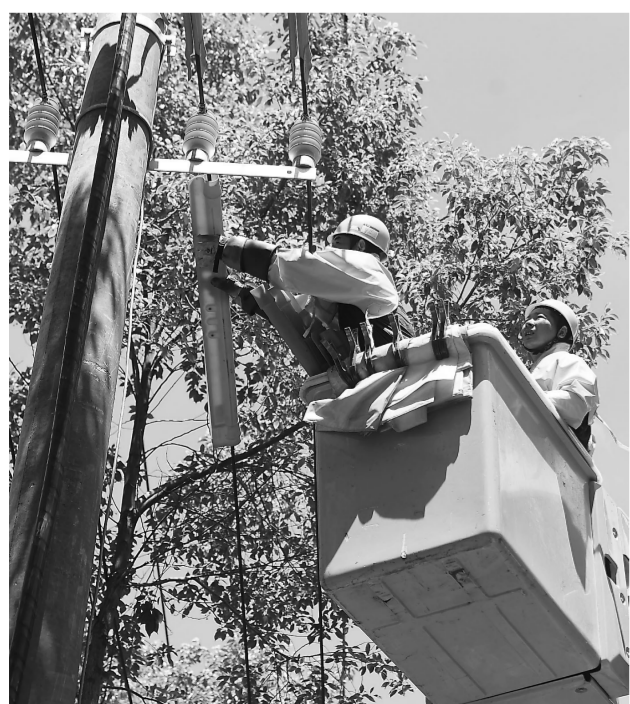
8月22日，国网高县供电公司带电作业班的工作人员，在不停电的情况下进行作业，提高线路供电能力，保障居民用电需求。特约通讯员 周亮摄
