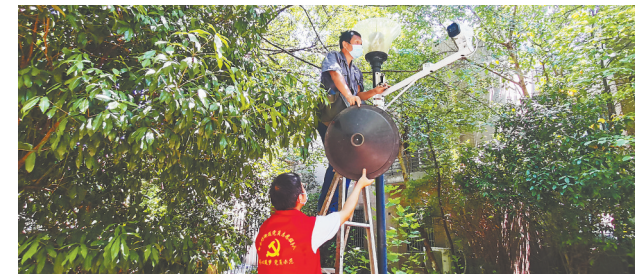
工作人员正在小区更换路灯。 本报记者 洪怀峰摄
