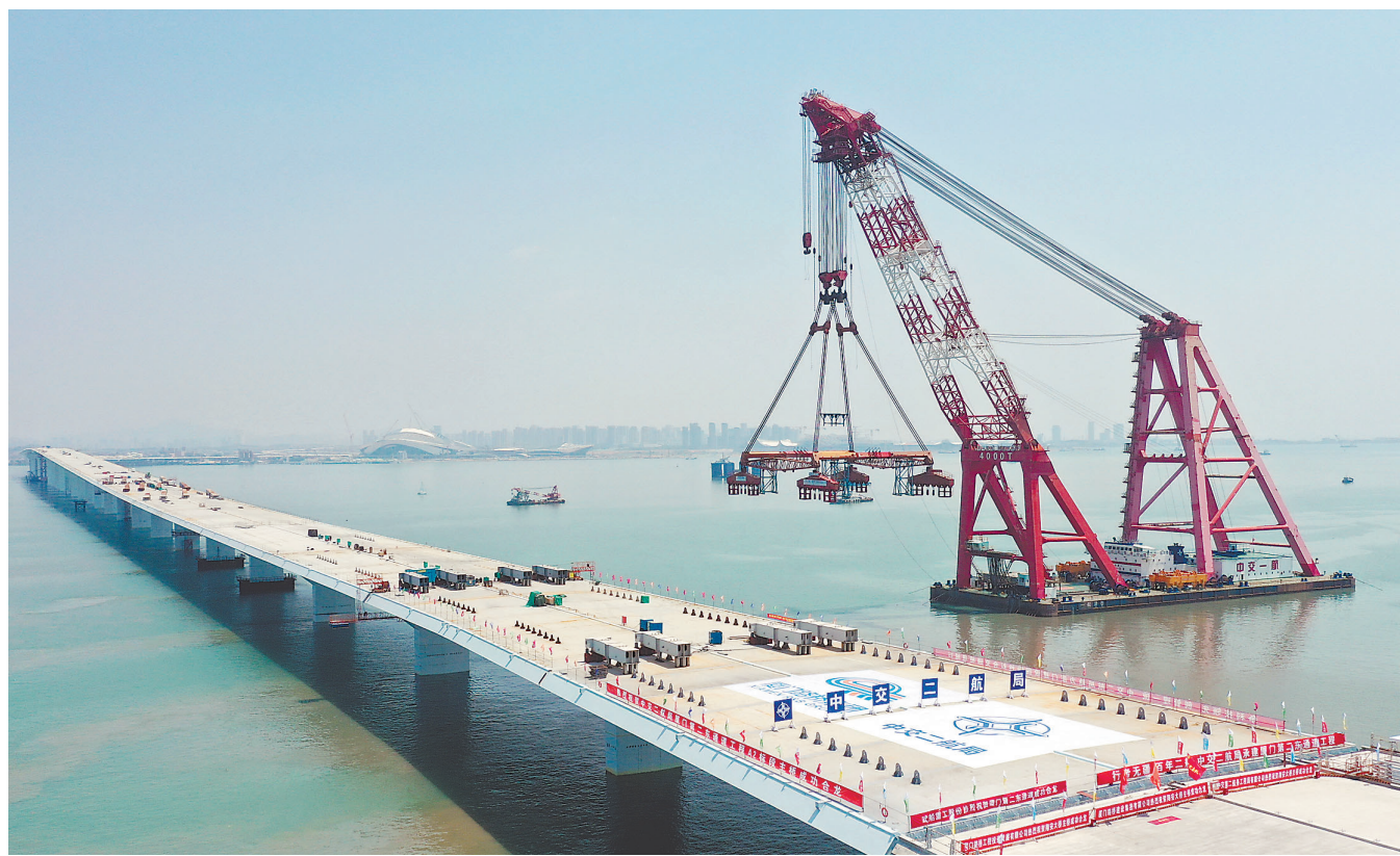
厦门翔安大桥主桥成功合龙。
