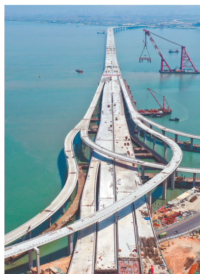
合龙后的厦门翔安大桥。
