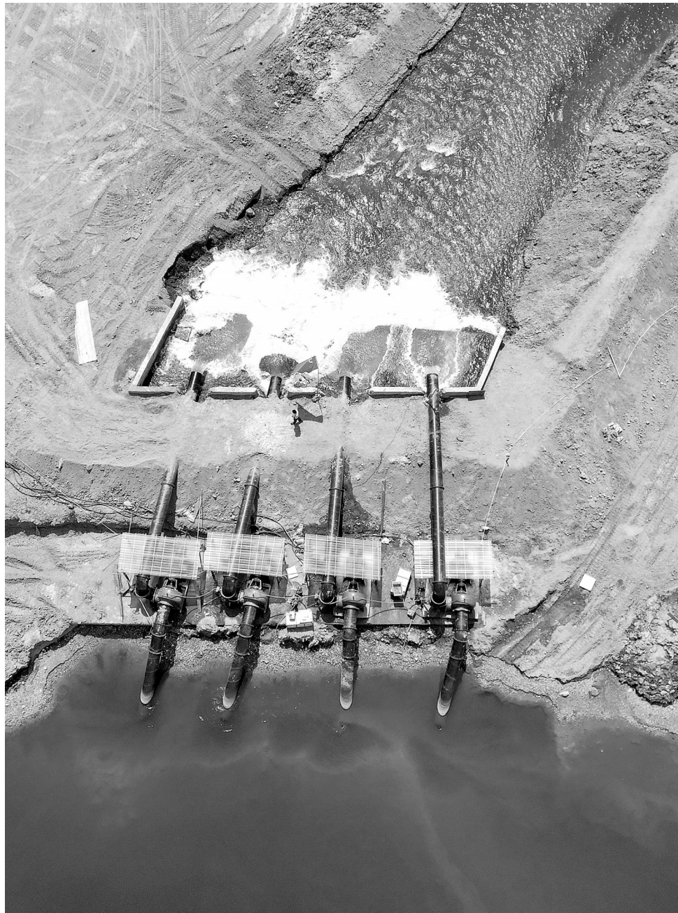
▲9月9日，万年县境内鄱阳湖支流乐安河梓埠段，4台水泵正在抽水抗旱。针对日趋严峻的旱情，该县紧急投入110万元，在乐安河梓埠段的河中央位置，临时建设一座440千瓦大型提灌站，抽乐安河水到玉津河，解决了10万亩农田用水需求。 特约通讯员 徐声高摄
