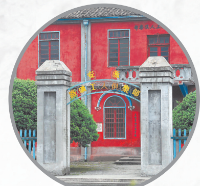
安源路矿工人俱乐部旧址。
