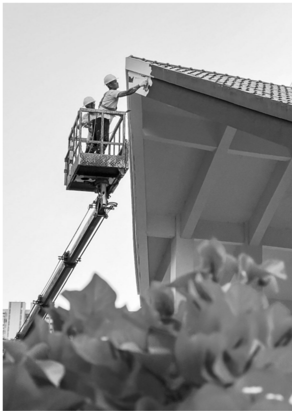
10月6日，在定南国家青少年足球训练中心二期项目建设现场，工人加紧施工作业，保障项目建设有序推进。
