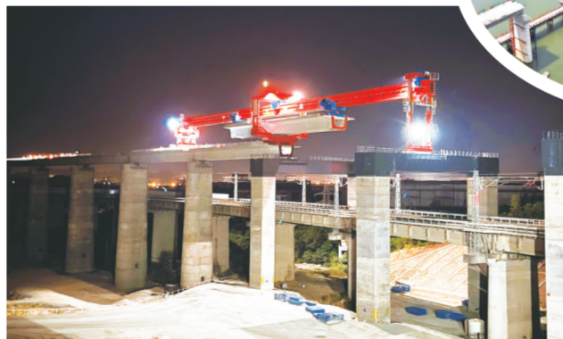
建设中的昌景黄高铁
