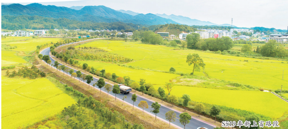
G220万载至袁州段改建工程摊铺施工
