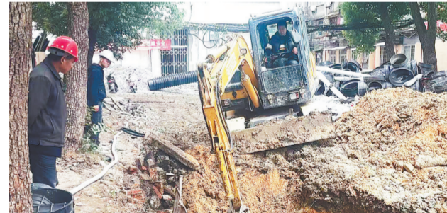
下水道开挖施工现场。
