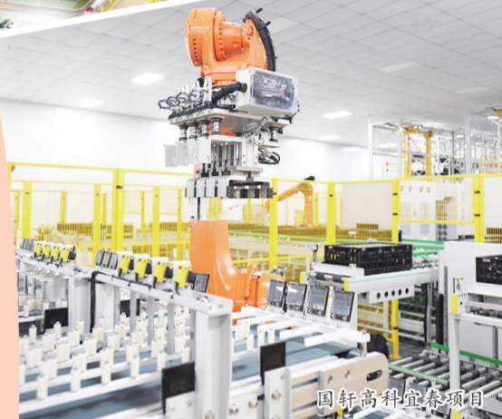
宁德时代宜春项目正加紧施工
