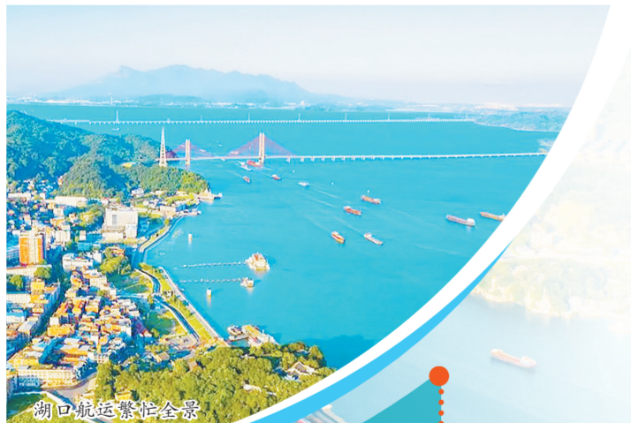
湖口航电枢纽全景
