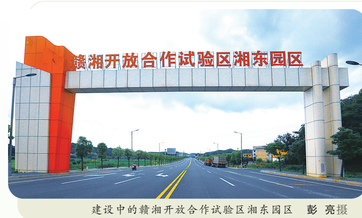
建设中的赣湘开放合作试验区湘东园区 彭亮摄
