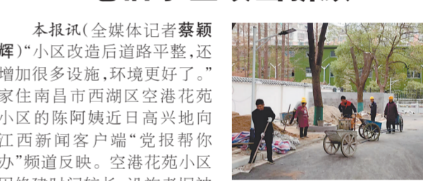
老旧小区改造施工。 本报全媒体记者蔡颖辉摄
