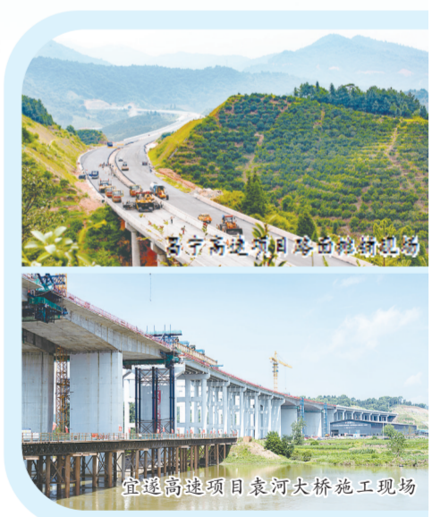
宜遂高速项目袁河大桥施工现场
