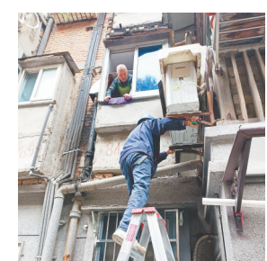
施工人员维修下水管。
