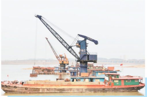
南昌市赣江城区段保供供水临时应急工程现场
