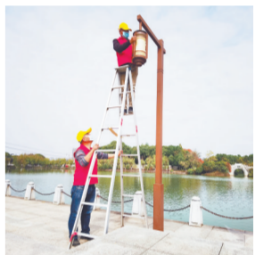
工作人员在维修路灯。本报全媒体记者 洪怀峰
