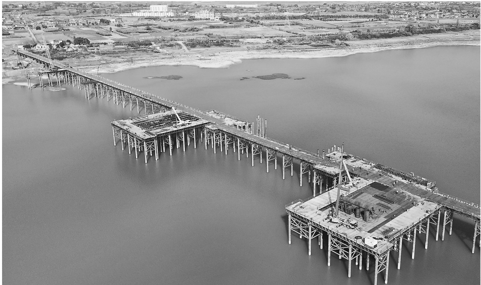
火花飞溅、吊臂挥舞……1月4日,昌九高铁南昌扬子洲赣江公铁大桥施工现场一派火热景象。据悉,南昌扬子洲赣江公铁大桥是昌九高铁重点控制性工程,大桥主桥三跨赣江,其中赣江南支主桥为预应力混凝土不对称部分斜拉桥,主塔为H型,塔高108米,全长510米。 本报全媒体记者 洪子波摄
