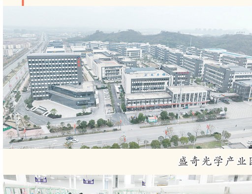
晶科光伏产业园
