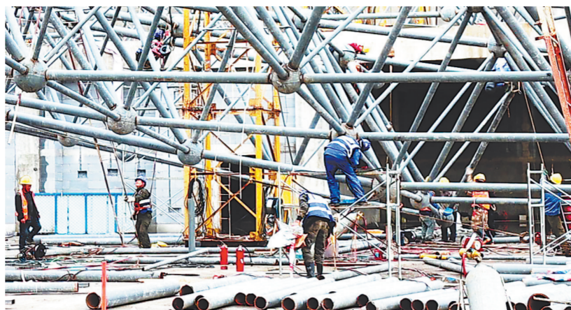
昌景黄高铁余干站施工现场,建设者正在作业。
