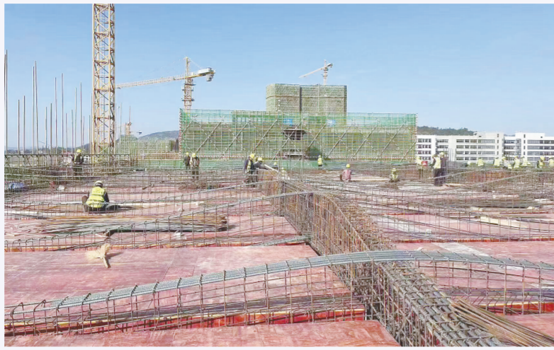
江西智慧海绵集团下属海绵建工公司承建的上栗动能转换产业园(一期)设计采购施工总承包项目——凯诺微工区 叶根摄
